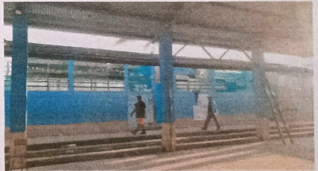
Foto 6: se botan todas las laminas del modulo # 1
