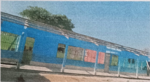
Foto 1: se da inicio a la desinstalación de laminas dañadas.
