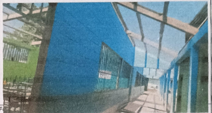
Foto 2: se botan todas las laminas dañadas
